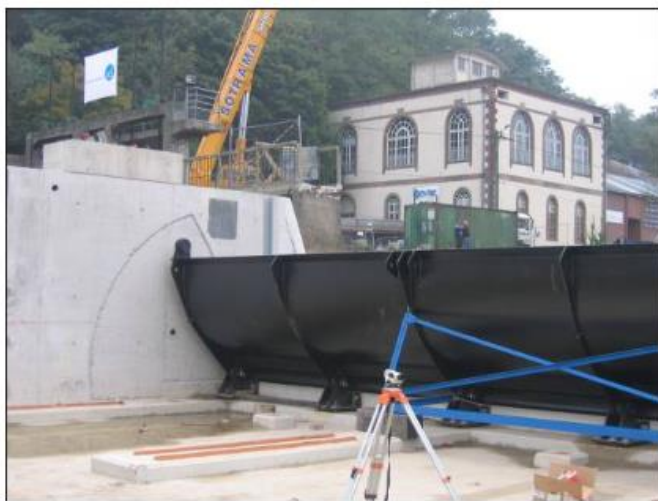
Clapet type ventre de poisson
